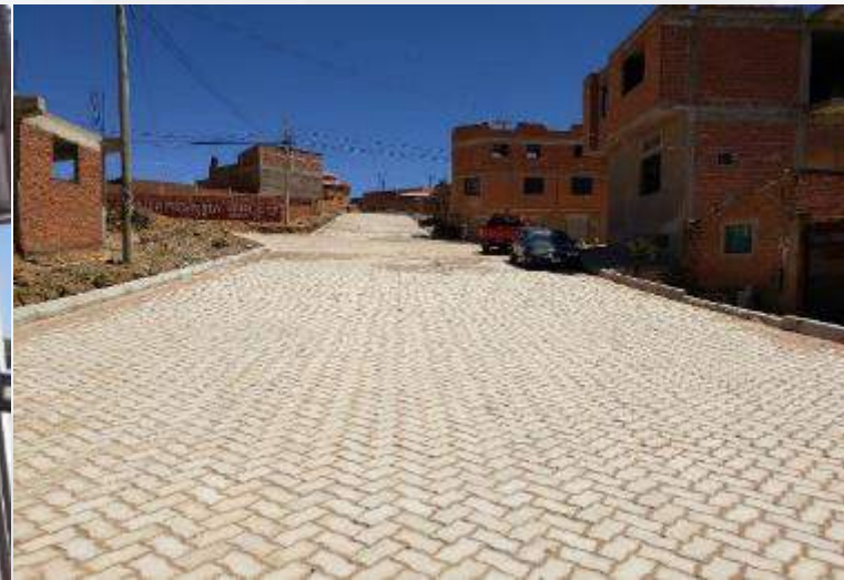
Enlosetado Barrio Belén (Sucre)
