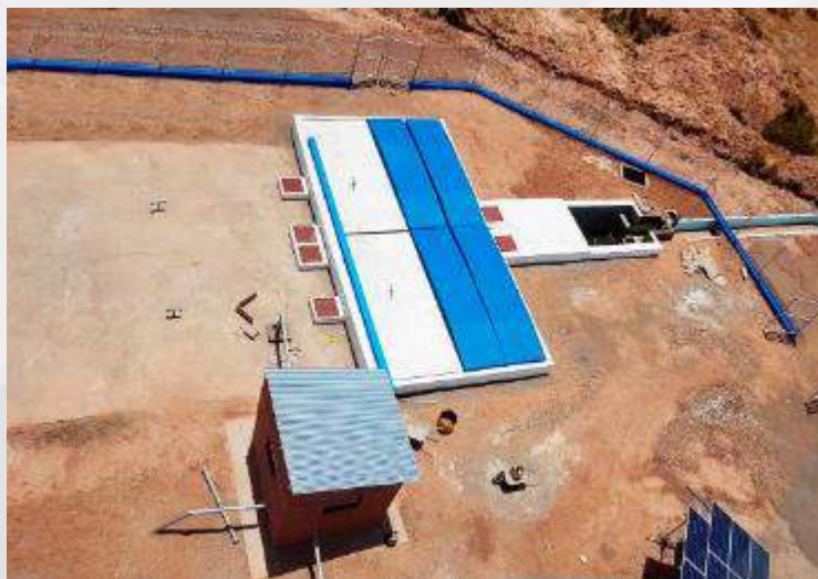
Sistema de Riego Tecnificado Santa María (El Choro)
