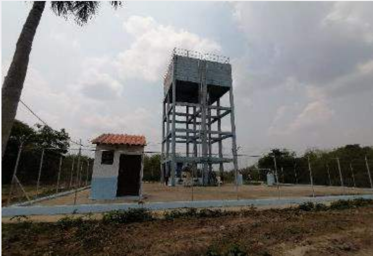
Agua Potable Buena Vista Santa Bárbara (Buena Vista)
